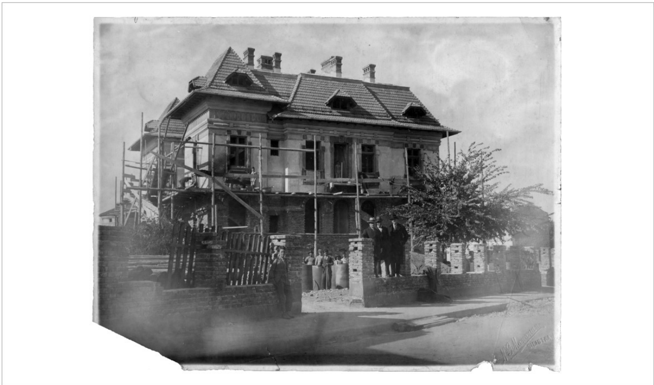
Fig. 6. Le palais de la Banque Nationale de Roumanie à Silistra durant les travaux de construction, 1926 (Bibliothèque de la Banque Nationale de Roumanie).
