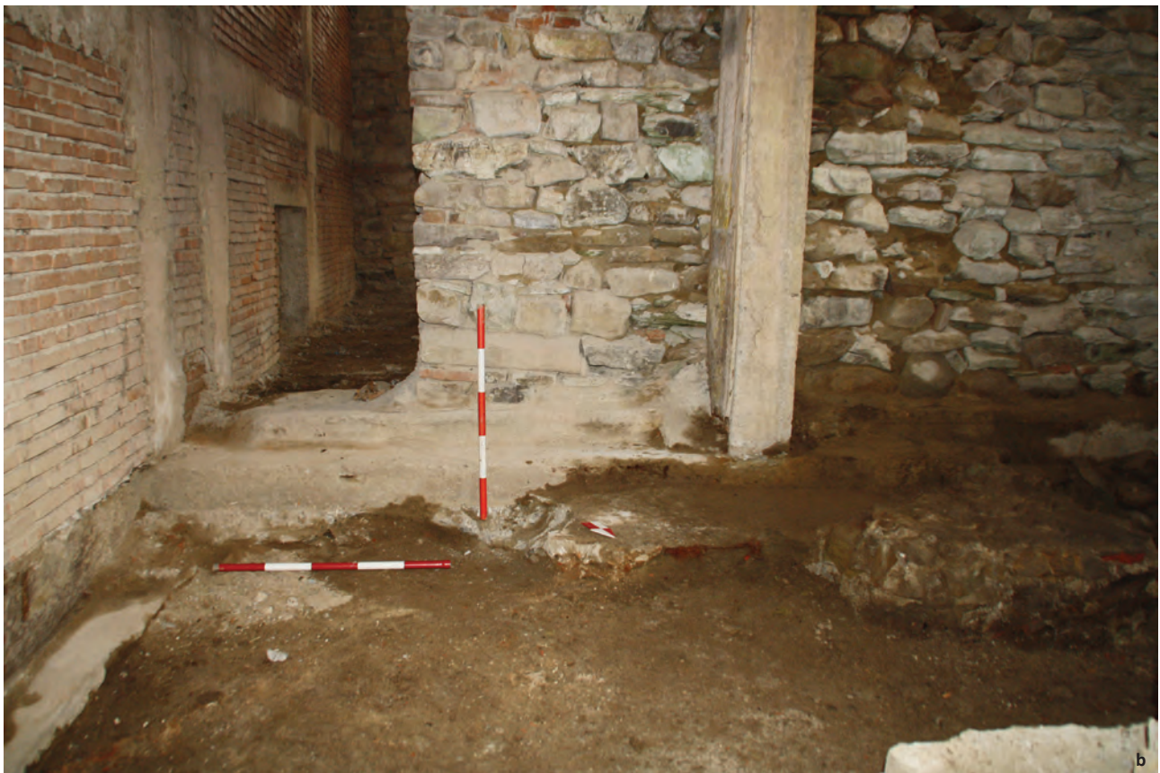
Figura 24. a–b) Încăperea II, imagini de ansamblu în timpul lucrărilor de coborâre a nivelului de călcare.
