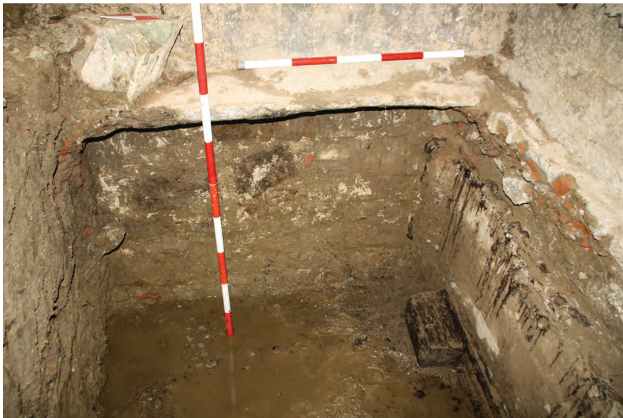
Figura 21. Secțiunea S.12, detaliu cu fundațiile celor două ziduri cercetate.
