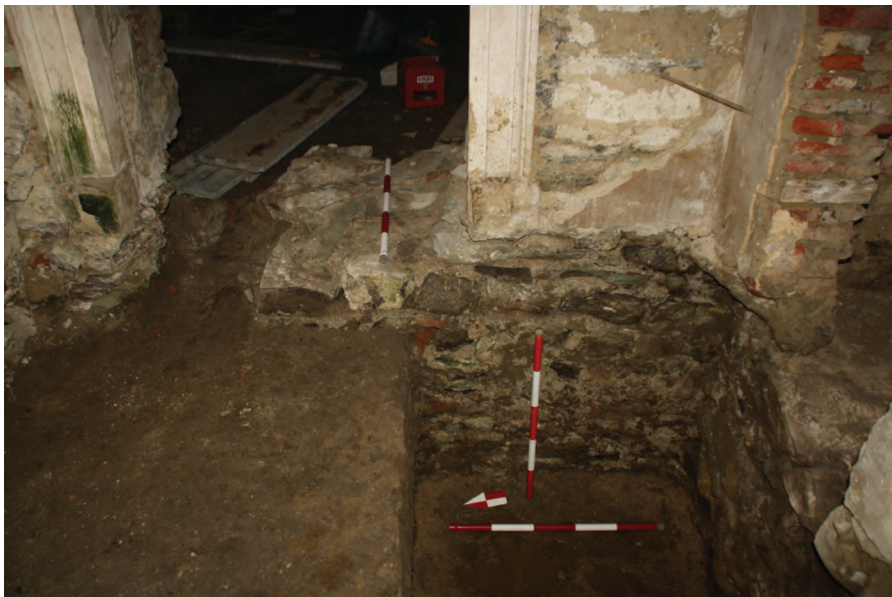
Figura 48. Detaliu cu fundația laturii de vest a corpului de gardă în interiorul actualei încăperi IX, cu intrarea principală în clădirea principală.
