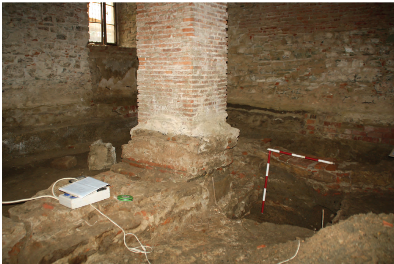
Figura 36. Vedere generală cu unul dintre stâlpii cercetați în secțiunea S.26.
