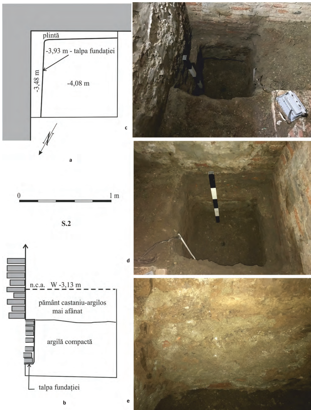
Figura 5. Pivnița: S.2 – a. plan, b. profil vest; fotografii: c. fundația sudică, d. fundația estică, e. detaliu fundație.
