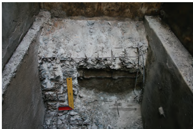
Figura 29. Mormântul cardinalului Iuliu Hossu: demontarea „cutiei” de beton. / The grave of Cardinal Iuliu Hossu: dismantling the concrete “box”.
