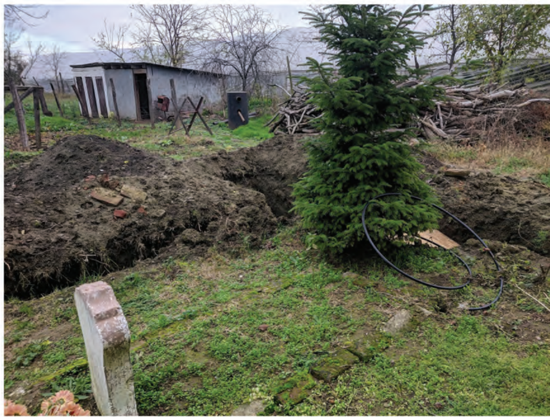
Planșa III. Fotografii efectuate înaintea cercetării.
